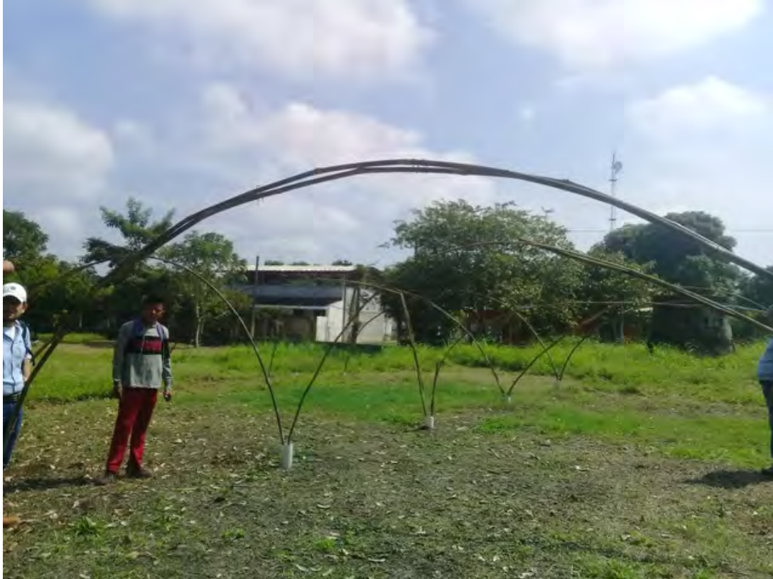
Figura 10. Construcción de Macrotúneles
